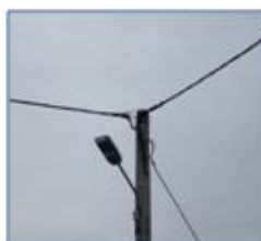
Réseau BT (Basse Tension = 230 ou 410 volts)
