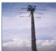
Réseau HTA (Moyenne Tension = 15000 ou 20000 volts)
