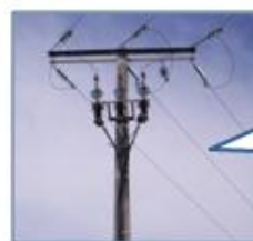
Réseau HTA (Moyenne Tension = 15000 ou 20000 volts)
