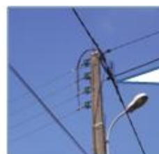
Réseau BT (Basse Tension = 230 ou 410 volts)
