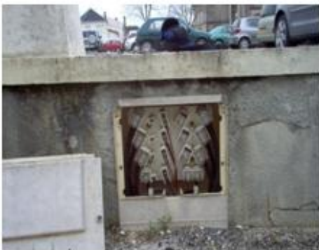
Coffret de réseau fausse coupure
